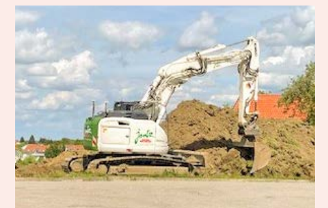
Die Geräuschkulisse auf der Baustelle begleitet die Anwohner noch längere Zeit.
